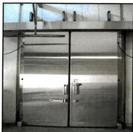
原料・製品一次保管庫(50
